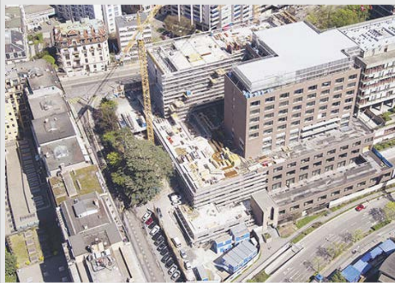
CMU étape 6, vue aérienne du chantier.
